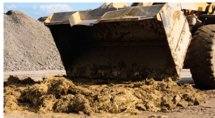
Mischen einer Wellerlehm-masse mittels Radlader Videostill, Kamera Daniel Beltrán
