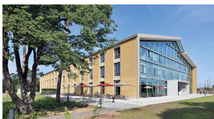
Stampflehmfassade, Alnatura Campus Darmstadt, haascook-zemmerich STUDIO2050 / Lehm Ton Erde Baukunst GmbH
