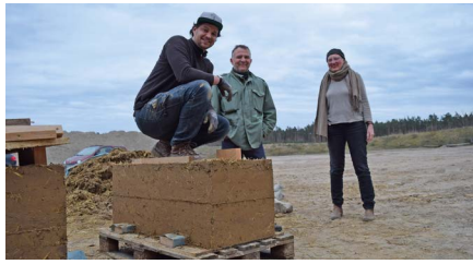
Wellerlehmblock nach der Entschalung aus einer wiederverwendbaren Verschalung. Foto Fabian Lehmann
