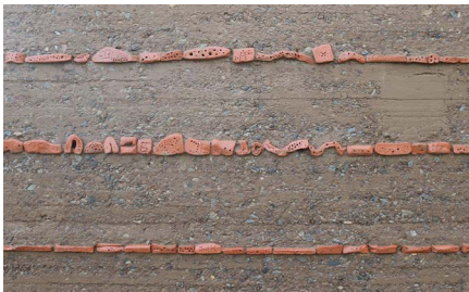
‚Bienensteine‘ aus schwach gebranntem Ton in Stampflehm (Testwand in Nebelin). Foto Ute Reeh
